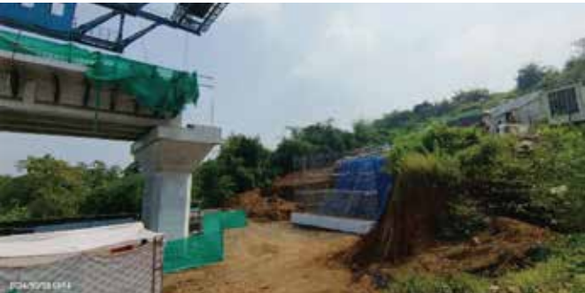
写真1 RRR-A工法（セメント改良補強土橋台）の現地施工状況
