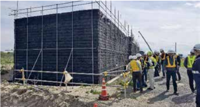
写真5 北海道新幹線 RRR工法建設現場の視察状況
