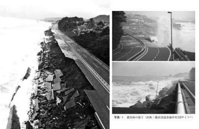
(a) 被災時の様子(出典: 横浜国道事務所 WEB サイトより)
