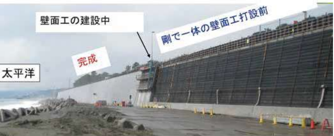
(b) 施工時の様子(東京理科大学福岡文夫教授撮影) 写真-1 国道1号西湘バイパスの海岸擁壁の採用事例
