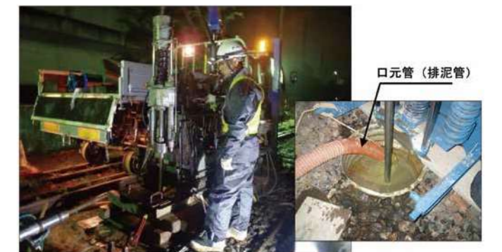
写真6 柱状改良体造成状況
