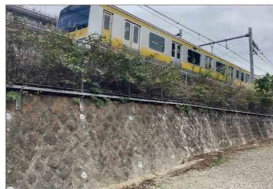
写真4 円形ザグリ工法施工状況
