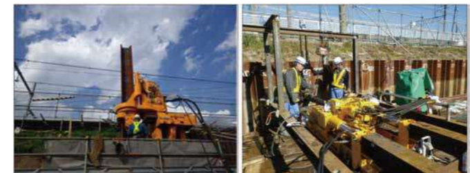
写真5 鋼矢板締切り工施工状況 (左:シートパイル打設、右:タイワイヤー孔削孔)
