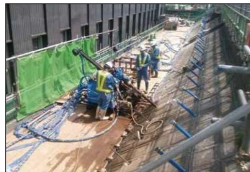
写真3 棒状補強材設置状況
