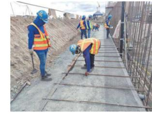
写真-4 型枠アンカー設置状況
