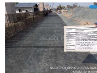
写真-1 ジオテキスタイル補強材溶接金網敷設置状況
