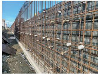
写真-11 鉄筋組立状況
