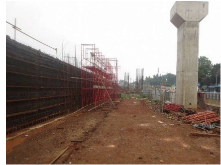
写真6 補強盛土完成
