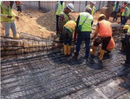
写真1 ジオテキスタイル敷設
