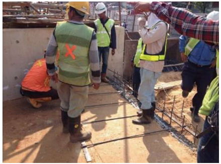
写真5 型枠アンカー設置
