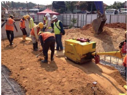
写真4 小型転圧機による転圧
