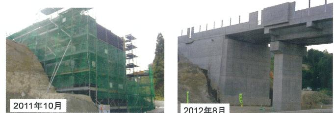
図-10. 北海道新幹線万太郎、高さ 13.4m の第二世代 RRR-GRS 橋台
