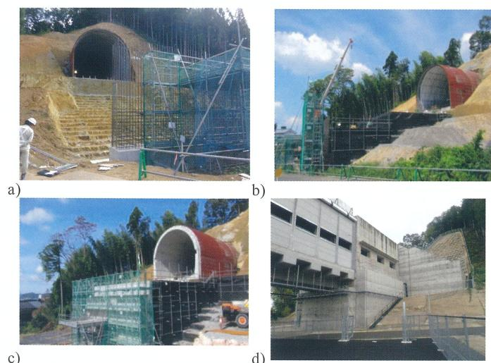
図-11. 北陸新幹線金沢・敦賀間第一下新庄での RRR-GRS 橋台（第二世代）（鉄道・運輸機構提供）: a) 地山斜面の段切りと橋台堅壁として剛な一体壁面工の鉄筋工組み立て; b) アプローチブロックと GRS トンネル坑門工の建設; c) 剛な一体壁面工の建設; d) 完成
