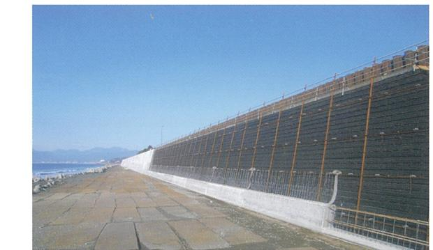
写真-4 西湘バイパスの高波波浪災害復旧事例
