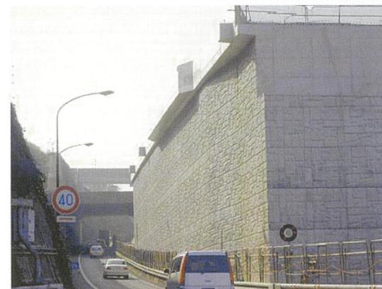
写真-5 横浜横須賀道路の施工例（最大壁高さ12.24m）
