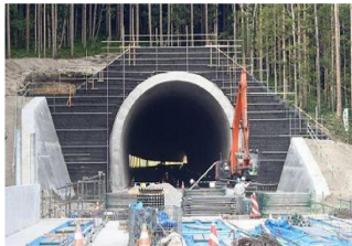
(b) トンネル坑門補強土工法
