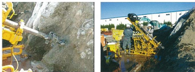
図-3.9 「硬質地盤用ラディッシュアンカー」の施工機械
