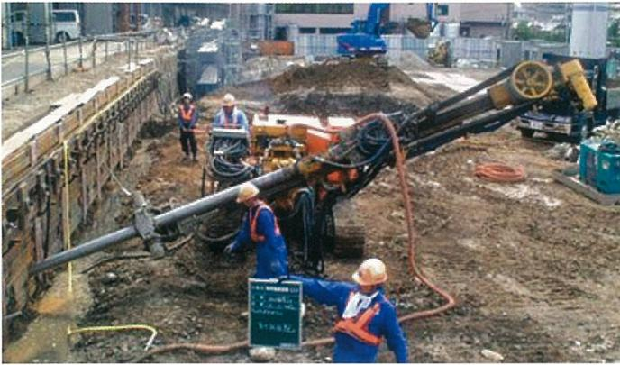
図-4.3 キャロットアンカーの施工状況
