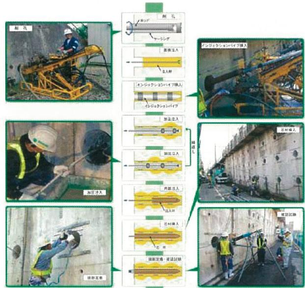
図-5.3 ロータスアンカーの施工手順
