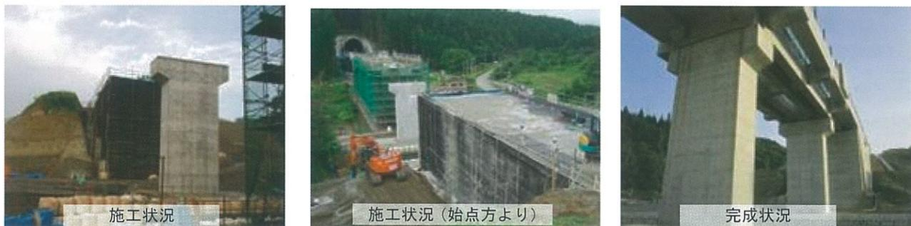
写真-2 北海道新幹線万太郎トンネル付近のGRS橋台<sup>1)</sup>
