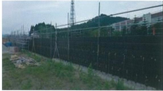
写真-1 剛な壁面を有するGRS擁壁<sup>1)</sup>
