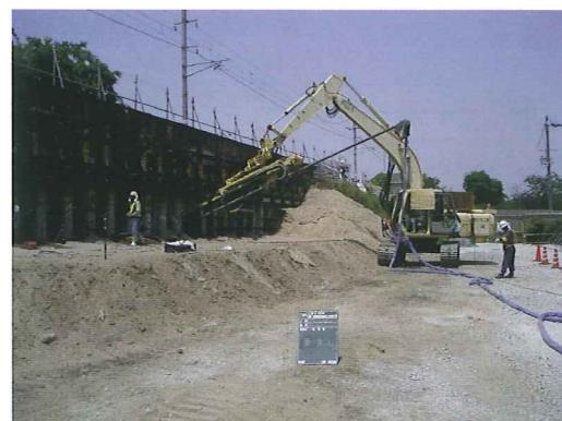
写真-2 ラディッシュアンカーアンカー工の施工状況
