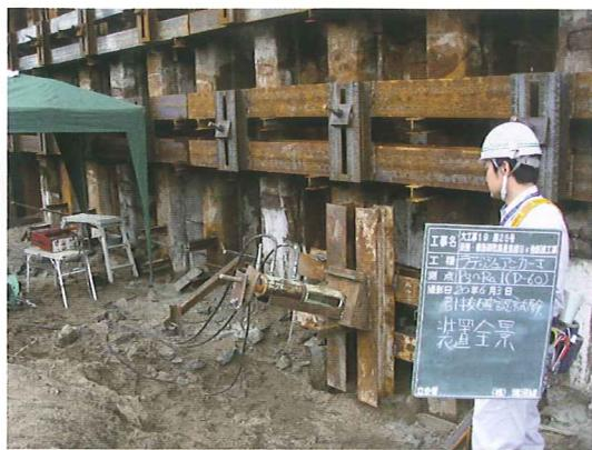
写真-3 腹起し、補強芯材の定着および引抜き試験状況
