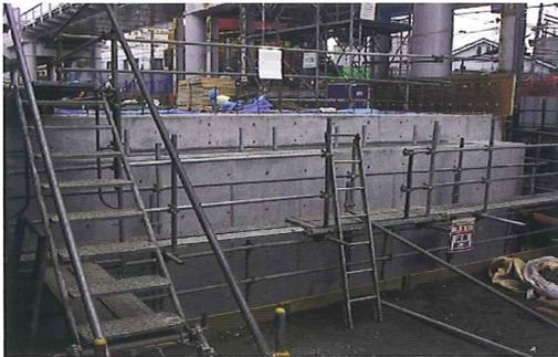
写真-4 橋台コンクリート打設完了
