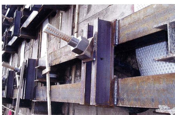
写真－4 腹起しおよび補強芯材の定着状況
