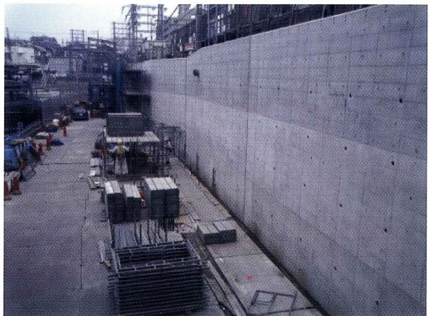
写真-6 壁面コンクリート完成状況
