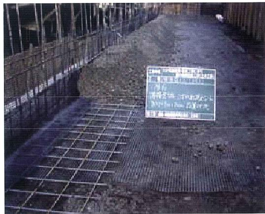
写真-2 仮抑え材(溶接金網の施工状況)
