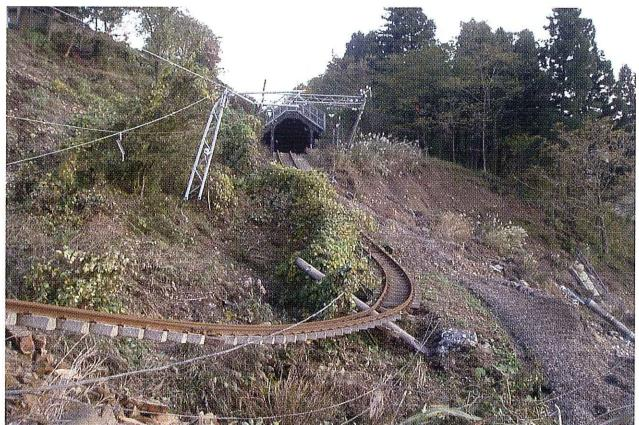
写真2.1 下り線の被災状況
