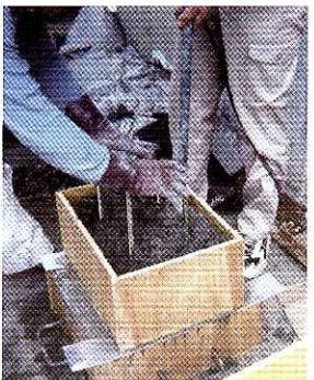
写真-2.3 試験体の作成状況
