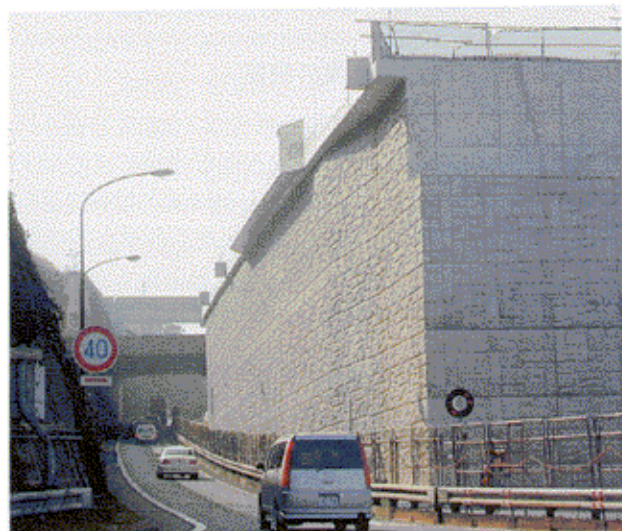
写真-5 完成(ONランプ)
