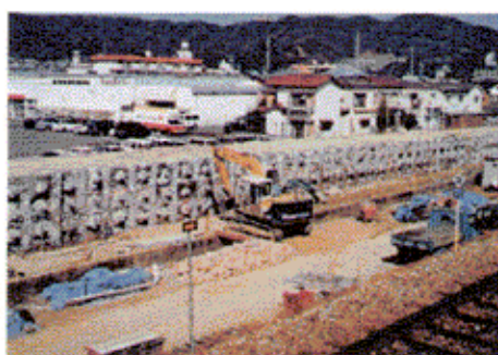
ラデッシュアンカー施工状況
