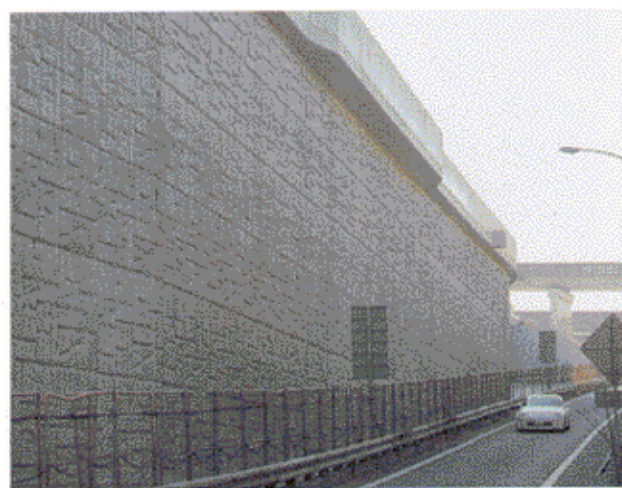
写真-6 完成(OFFランプ)
