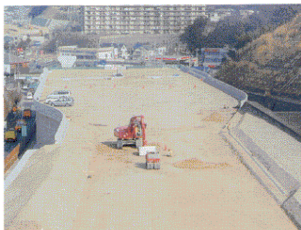
写真-4 完成(料金所)
