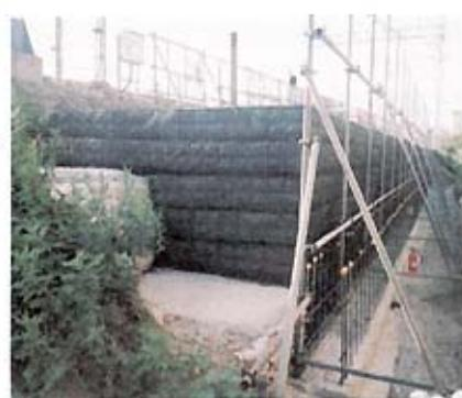
当社におけるRRR工法は、関西国際空港への主要アクセスでもある南海本線の連続立体化工事において、大阪府泉大津市で施工しております。連立高架事業のうち、当工区は擁壁基礎の杭打設が不可能な場所であるため、橋台までの取り付け盛土部をRRR工法による補強盛土工(延長58m)で施工いたしました。今後、軌道切替えを順次行い、平成20年度までに延長188mの施工を予定しております。
