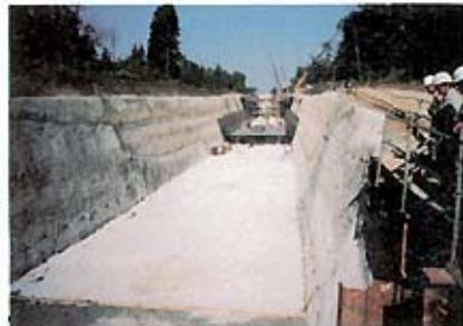
つくば市の島名工区を紹介いたします。この工事では、延長1km、深さ2~10mのU型擁壁を構築しました。RRR工法により1:0.35の勾配で掘削した切土法面にコンクリートを直打ちしています。この工事の特徴は、型枠に大型移動式支保工を導入したことあります。これにより、大幅な工期の短縮に成功し、天然記念物であるオオタカの繁殖時期を避けて施工する工程上のハンデを克服することができました。
