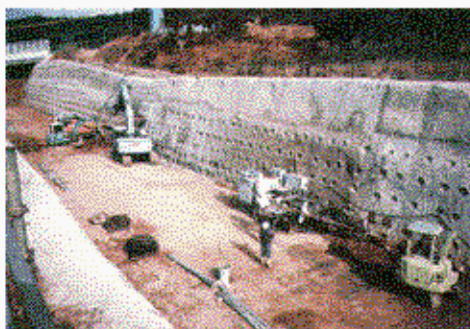
写真-2 施工状況(大径補強材：九州新幹線)
