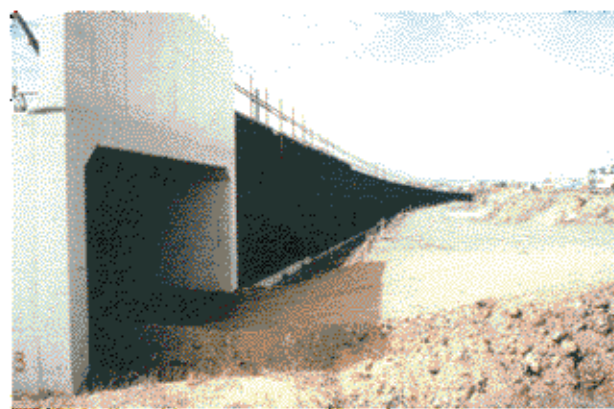
写真-3 補強盛土全景
