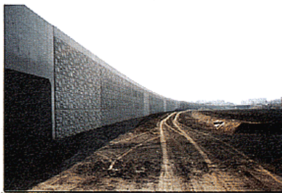
写真-4 壁面工全景
