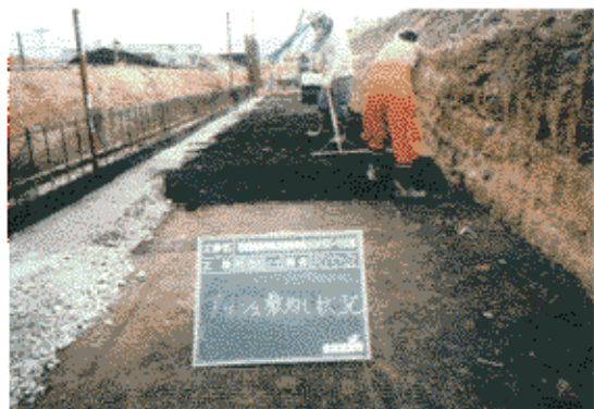
写真-2 補強盛土の施工状況
