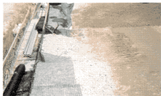
写真-4 碎石まき出しと補強材の巻き上げ状況
