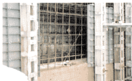
写真-5 移動式鋼製型枠施工状況(1)
