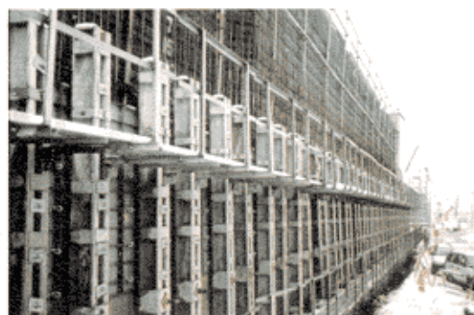
写真-6 移動式鋼製型枠施工状況(2)
