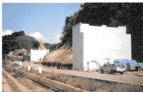
写真-1 現場状況
