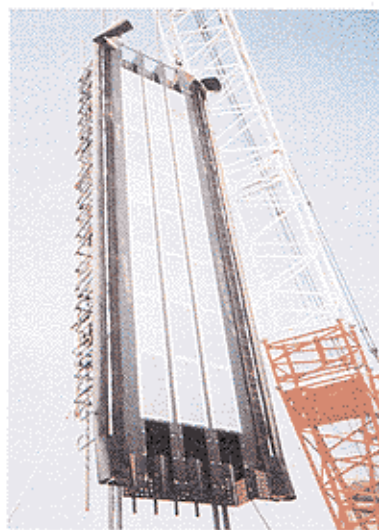
写真-1 通水ボックス付き鉄筋籠施工状況
