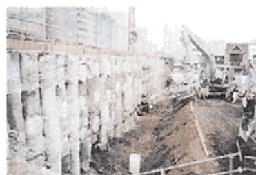
ラディッシュアンカーによる 斜面急勾配化
