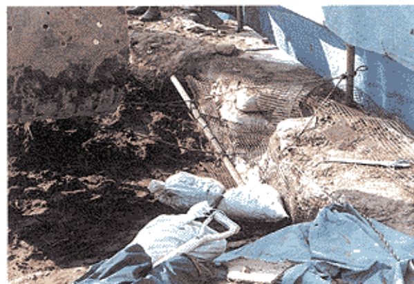
写真-6 実物大盛土の定着部引張り試験状況
