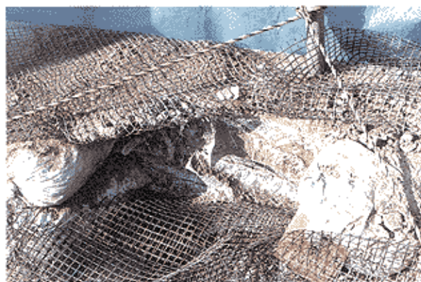
写真-5 実物大盛土の定着部の解体
