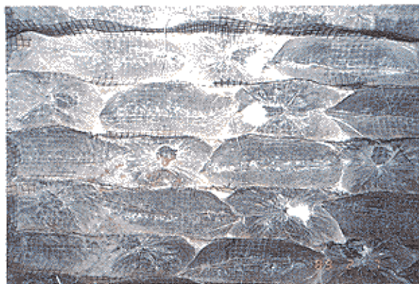
写真-4 振動実験後における壁面部の定着状況
