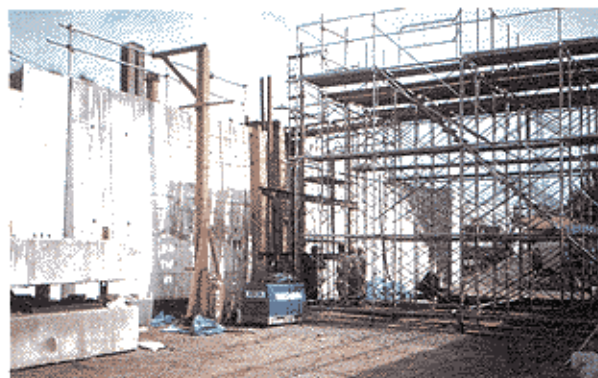
写真-7 壁頂水平載荷試験状況
