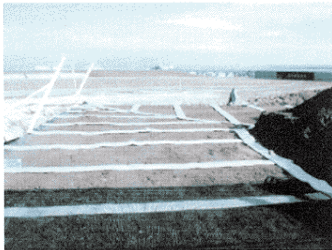
写真-2 水平ドレーンの設置状況
