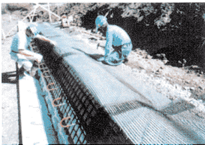
写真-1 L型金網を用いた仮抑え部の施工状況
