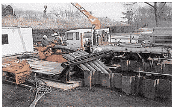
写真-1 試験施工状況
