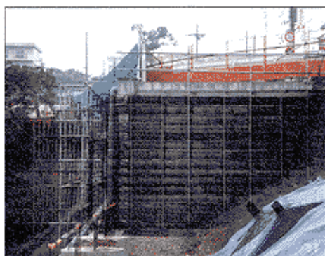
興子街路築造/神戸市都市整備公社
