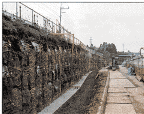
東金道路東金IC工事/日本道路公団
