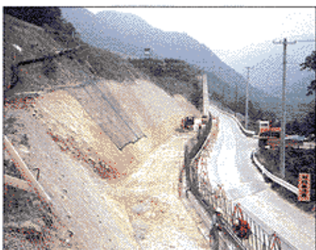
山形自動車道滑川工事/日本道路公団
