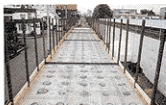
写真1 EPSの孔内に補剛アング打設状況
