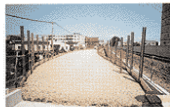
写真2 補強盛土完成状況
