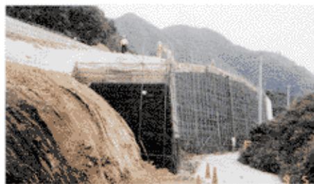
写真-1 施工状況
