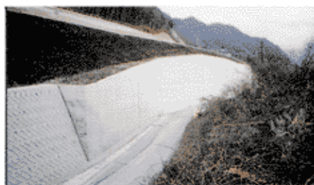
写真-2 完成状況
