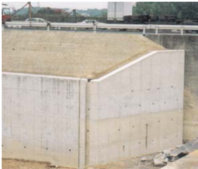
壁面完成状況(大高改良)
