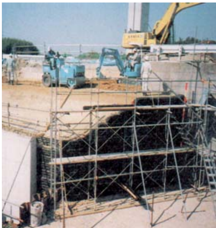
補強盛土部完成状況(大高改良)
