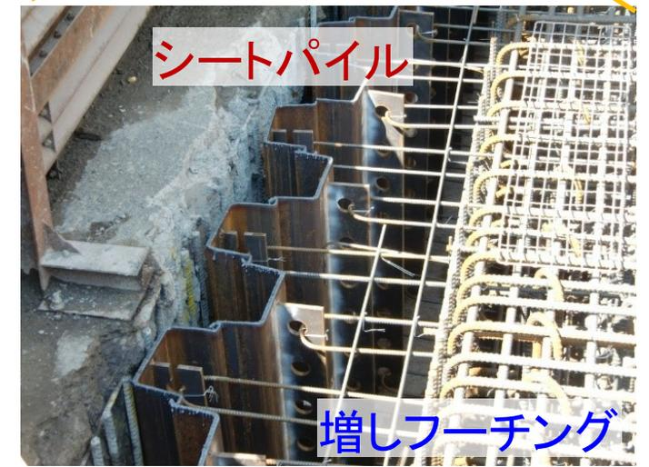
■ シートパイル補強工法を提供し、導入支援を図り、被災リスク低減に寄与
