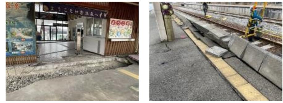
◎敷浪～南羽咋間（電柱傾斜・軌道変位・軌道沈下）
