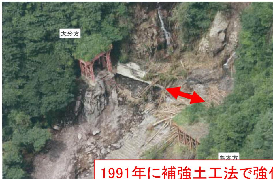
1991年に補強土工法で強化復旧した部分⇒損傷したが生き残った
