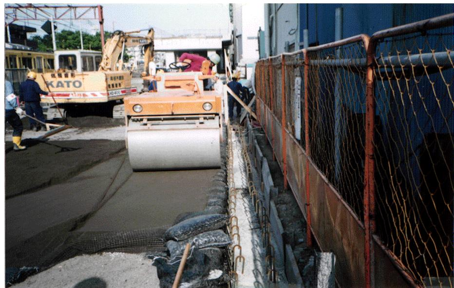
■ 盛土体の内部からコンクリート外型枠を支保
