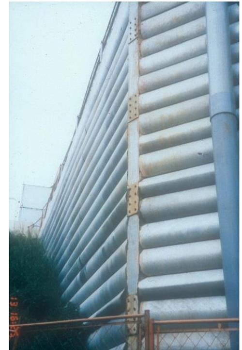
盛土の鉛直圧縮⇒柔な壁面工の変形 ⇒壁面工と盛土との
