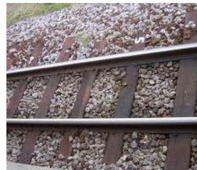
・沈下、追加盛土によるバラスト層厚の増大や土質の不確定性などから、ラッシュアンカーが適用できないことがある。
