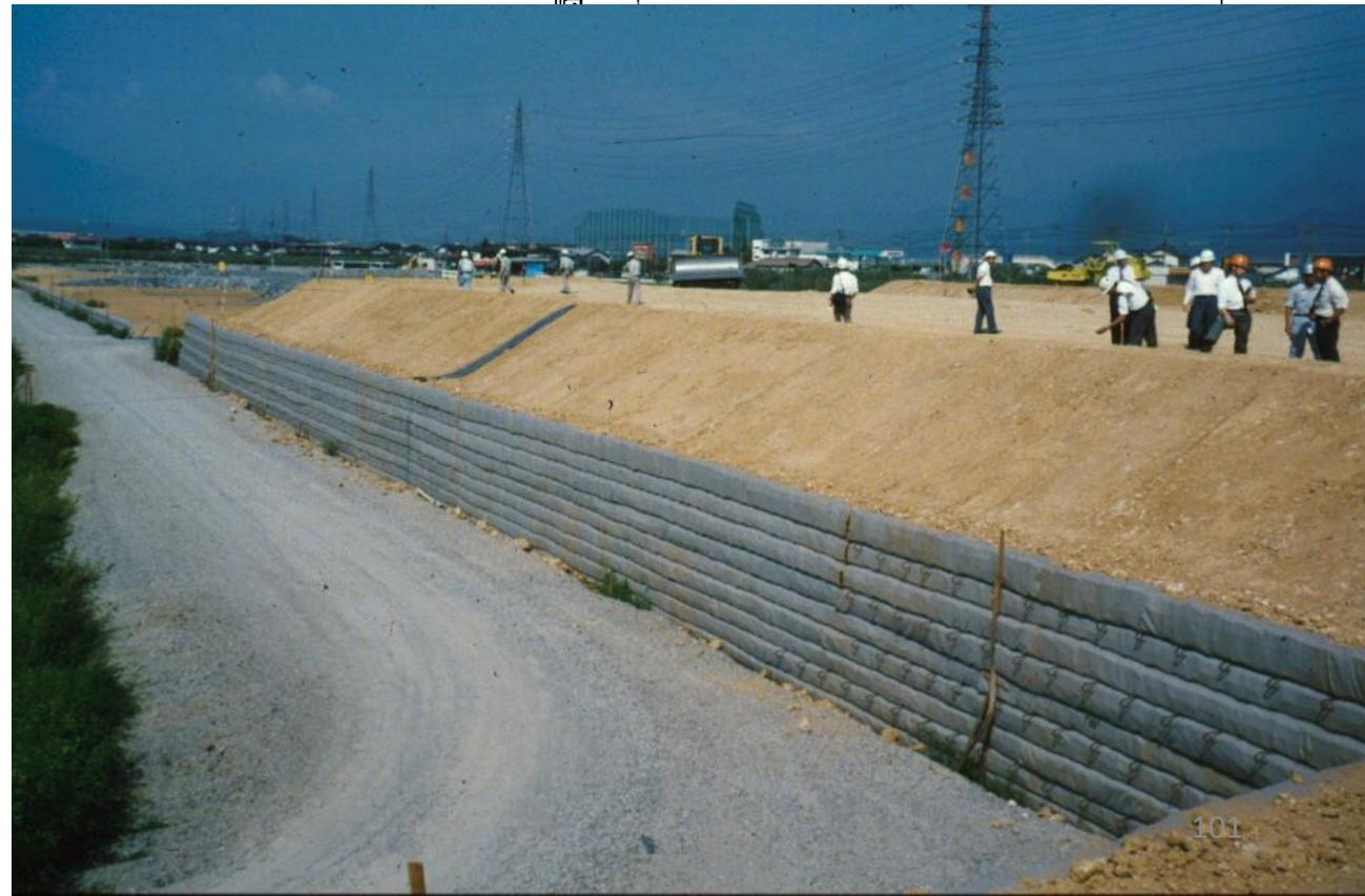
● プレロード盛土建設による地盤沈下は1m程度
