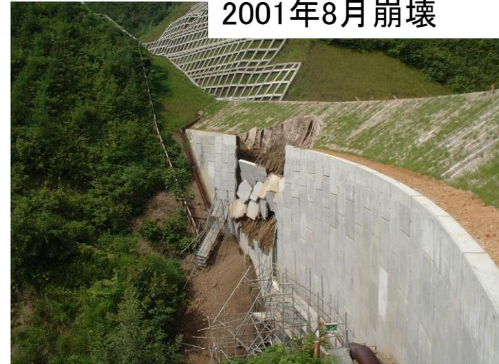
■ 「分割パネル式・ブロック式等の壁面工を用いた補強土擁壁」では、局所的に弱部があつて破壊が生じると、全体破壊への連鎖が生じる可能性（現在のGRS擁壁の安定解析では、この破壊メカニズムは検討していないが）。
