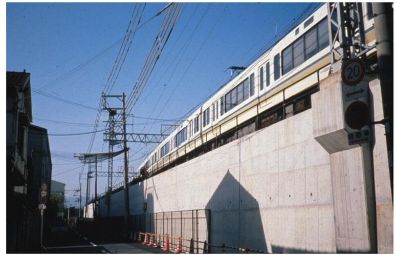
分割パネル式壁面工では、乾燥あるいは飽和した細砂盛土材が流出する虞
