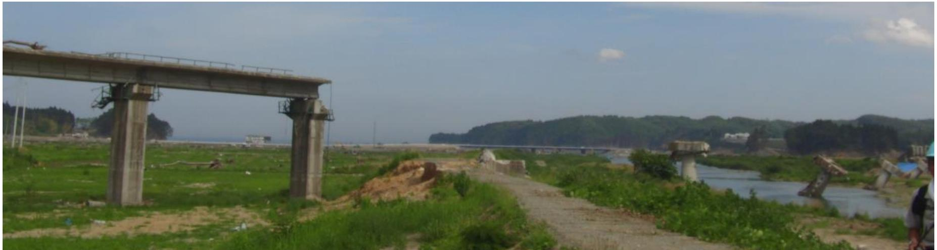
上流側か見たJR東日本気仙沼線本吉駅陸前小泉駅間の津谷川橋梁（橋げた流失、橋脚損壊：津波は高架橋の桁を越流：龍岡撮影）
