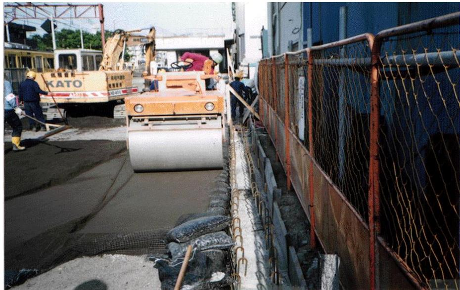
4) 盛土体の内部からコンクリート外型枠を支保
