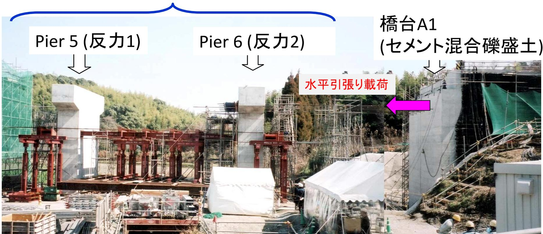
GRS橋台は、抗土圧構造物ではなく、盛土が壁面工を支えている
