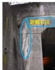
パラベットのひび割れ、漏水
