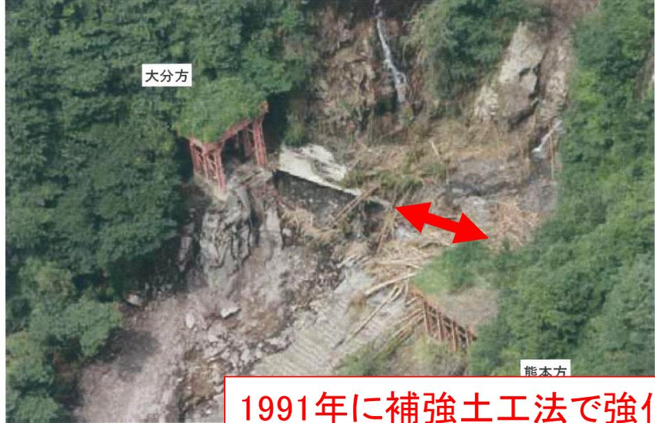
1991年に補強土工法で強化復旧した部分⇒損傷したが生き残った
