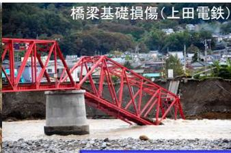
橋梁基礎損傷(上田電鉄)
