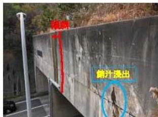
パラベットクラック、浸出水、道路側へ傾斜
