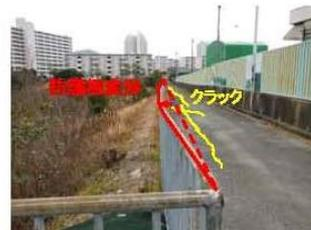
法面上部舗装ひび割れ、防護柵変形
