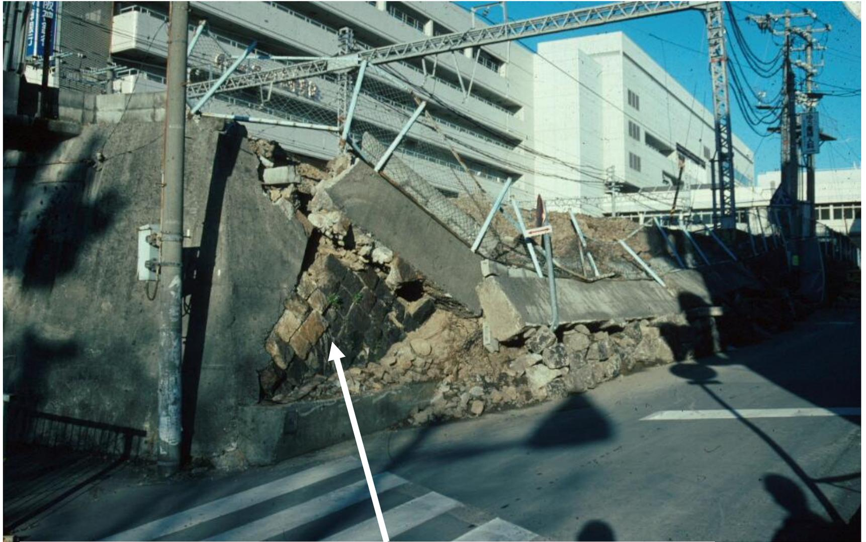
石積み擁壁の崩壊に伴う橋台の取付盛土の崩壊
