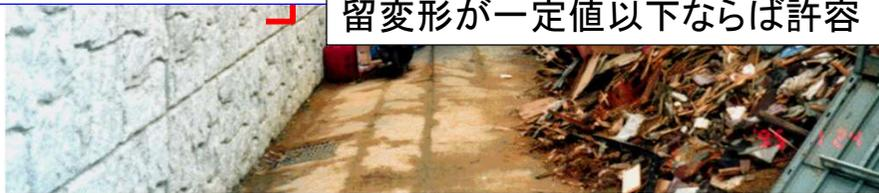
また、2b)は、盛土の内部摩擦角の設計値 $\phi_{design}$ を簡略に「盛土が締固めの程度に関わらず一定値」に設定し、その値が締固めが良いほど過小評価されていることによる余裕です。この補強土擁壁では、 $\phi_{design} = 35$ 度です。
