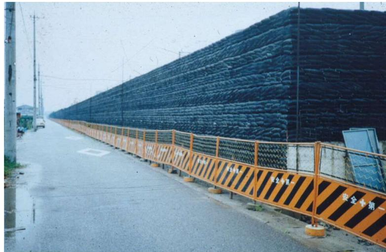
この段階は剛で一体の壁面工の建設の前なので、盛土荷重によって支持地盤と盛土が変形して沈下しても、補強材と壁面工の連結部での損傷は生みません。
