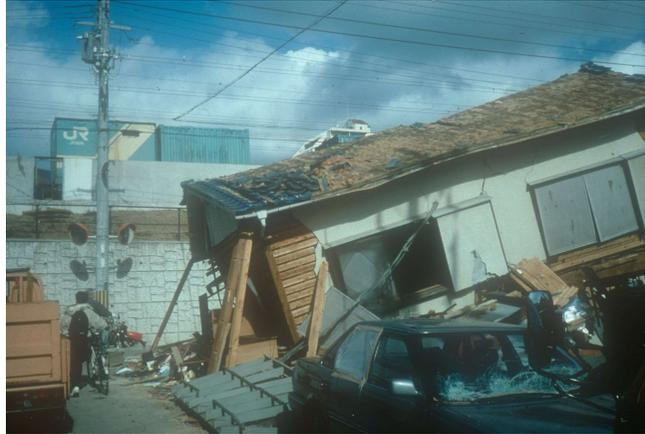
①水平地震荷重=重量×水平地震加速度は、1階部分の方が大きい
