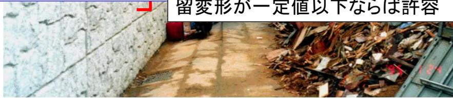
一方、1)は、設計地震時安全率の許容最小値を1.5とすることによる余裕です。この安全率は、補強材材料安全率1.25と構造物全体の安定に関する安全率1.25で構成されています ( $1.25 \times 1.25 \approx 1.5$ )。本来、この安全率は設計・施工の管理レベルが向上すれば低減できます。
