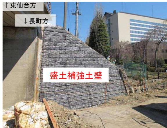
続いて、これは2011年東日本大震災による仙台付近の橋台付近の土留め壁の崩落であり、それを「剛な一体壁面工をもつジオテキスタイル補強土擁壁」で強化復旧した例です。
