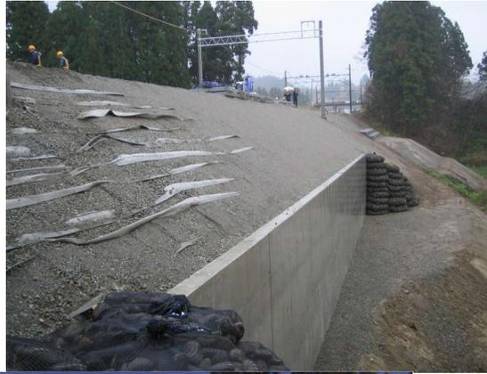
近接箇所での剛な一体壁面工を有するジオテキスタイル補強土擁壁での強化復旧です。
