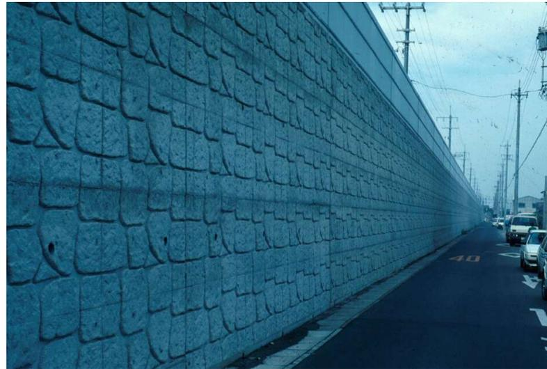
盛土荷重による盛土と地盤の変形が収束してから、薄いRC壁面工を補強材と連結して盛土と一体になるようにコンクリートの現場打ちで建設します。
