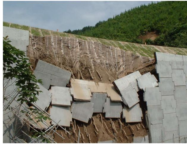
これは、日本での、一部のパネルが崩壊すると、擁壁全体の崩壊に発展した事例です。
