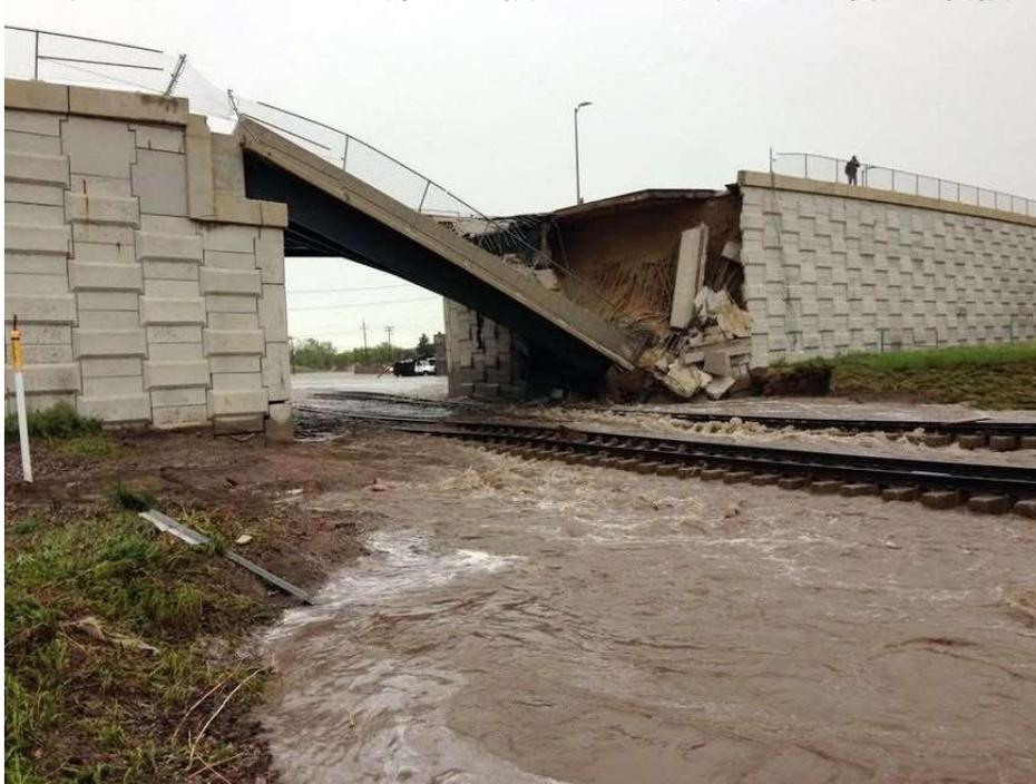
これは、洪水による洗堀によって壁面工の基礎の支持地盤が洗堀されて、橋桁を支持していた壁面工が不安定化したことによって生じた崩壊です。
