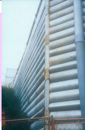
1963年にフランスのアンリー・ビダール(H. Vidal)氏により考案された補強土壁工法。日本では1972年に日本道路公団の中央自動車道で初めて採用。補強土擁壁工法の先駆け
