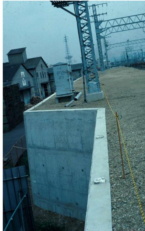
これは、大型の電柱基礎を杭基礎を用いずに補強土擁壁で支持した例です。
