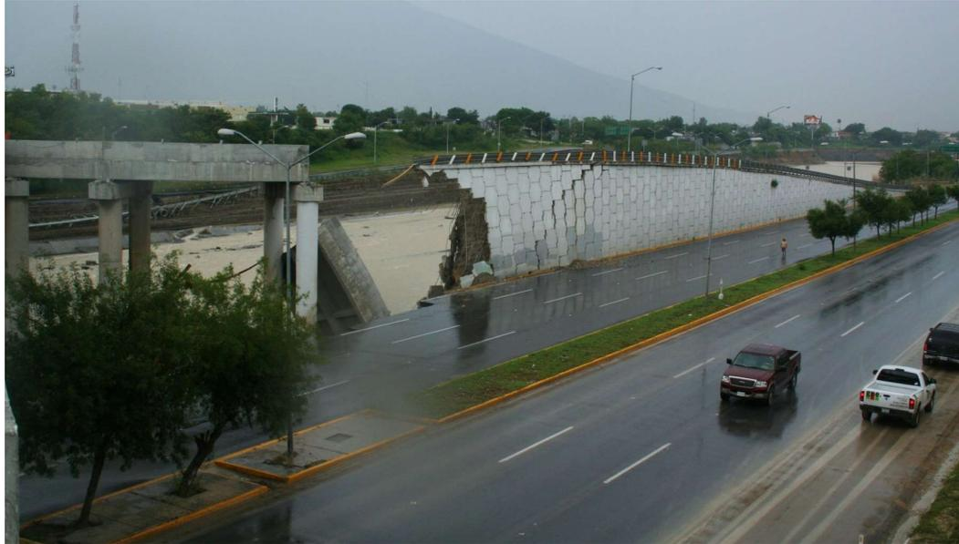
これも、壁面工が分割パネルであったため、壁面工の支持地盤の洗掘によって一部のパネルの不安定化し、それが全体の崩壊に発達した例です。
