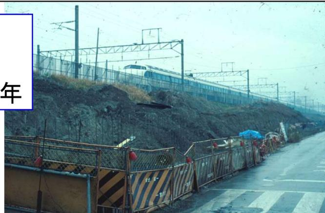
再度ですがこれが、既設の盛土斜面に腹付けしたGRS擁壁の例です。1990～1991年に建設されています。
