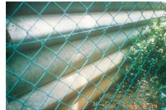
剛性が高く非延伸性の金属製帯材の補強材を用いても、壁面の変形、それに伴う盛土全体の変形は小さい。
