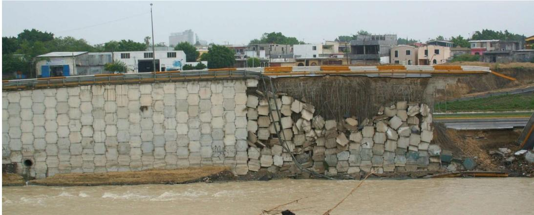
擁壁の崩壊が、壁面工の基礎地盤の洗堀から始まっていることが分かります。
