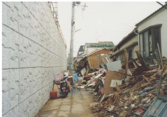
一方、1995年神戸地震で崩壊しなかったJR西日本神戸線の「たなた地区での剛な一体壁面工を持つジオグリッド補強土擁壁」では、例外的に補強材は長さが一定で $L/H= 0.4$ と短くしていました。
