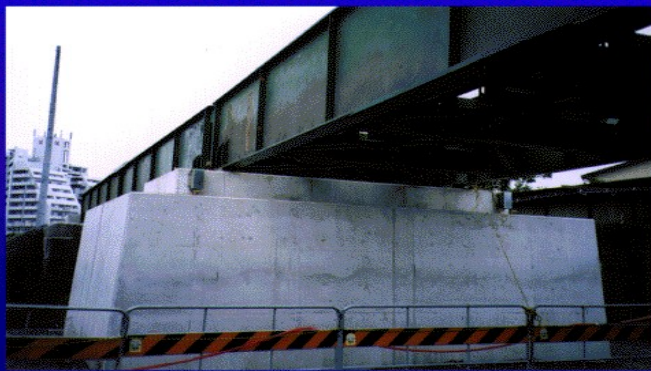
PL/PS補強土橋脚の完成状況
