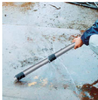
加圧注入状況(清水にて噴射)
