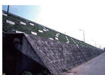
④斜面補強工(道路盛土)
