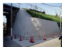
⑤既設石積補強工(鉄道盛土)
