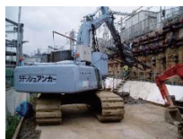
①③盛土のり面急勾配化工(壁面打設前土留め状況)
