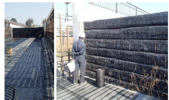
写真-2 渡辺建設工事現場から見た増淵組の完成した補強盛土の仮押さえ部
