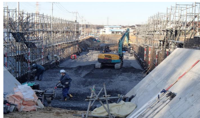
写真-1 締め固め作業[宇都宮土建工業(株)]
