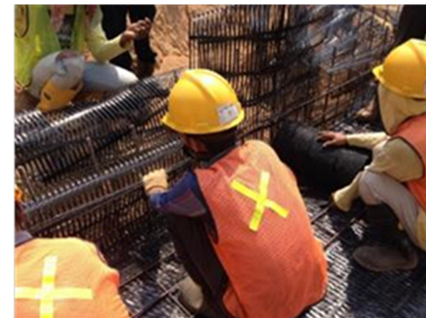
写真-1 仮抑え材の溶接金網設置状況
