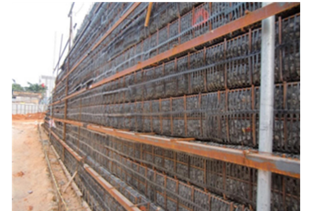
写真-3 補強盛土体の構築状況
