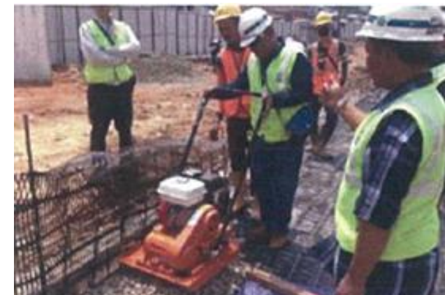
写真-2 仮抑え部の構築状況
