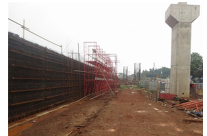
写真-4 補強盛土完成
