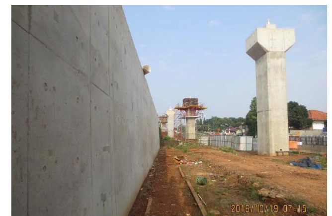
写真-5 RRR-GRS擁壁の完成
