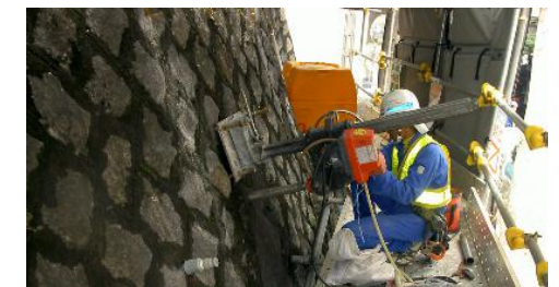
写真 4.1 コアドリルによる削孔
