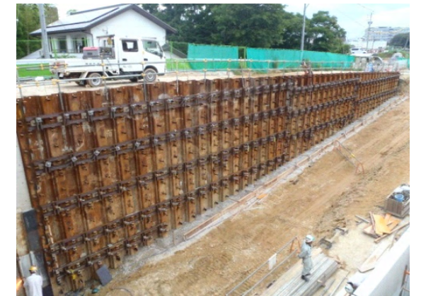
写真3.5 施工状況(ラディッシュアンカー打設完了)
