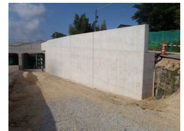
写真4.1 施工完了全景
