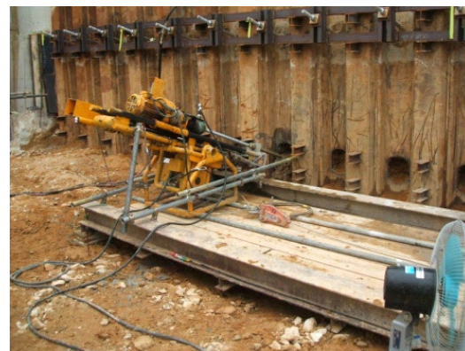
写真3.1 自穿孔型ラディッシュアンカー施工状況
