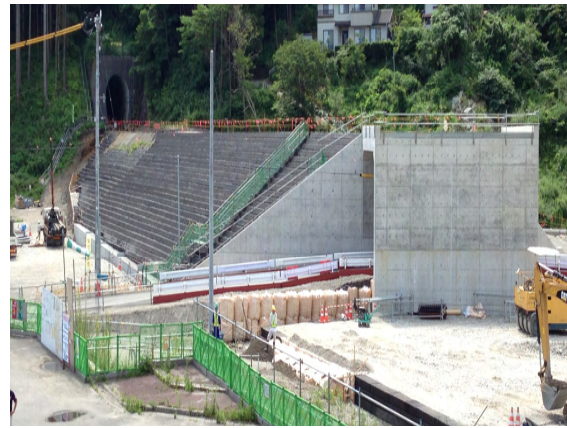
見学会施工場所
