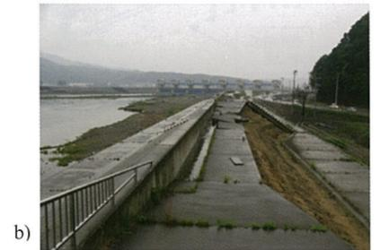
図3 a)天端被覆工のコンクリートスラブと下流側裏のり面の最上段のコンクリート工がはぎ取られた防潮堤(大船渡市三陸町越喜来漁港付近)：b)天端被覆工のコンクリートスラブが移動し下流側裏のり面最上段の被覆工のコンクリート工がはぎ取られた防潮堤(宮古南津軽石付近)。これらの箇所の延長上では全断面が消失した箇所がある(筆者撮影)
