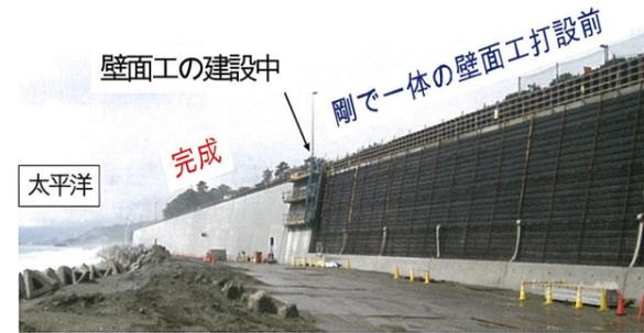
図6 平成19年9月6日～7日に台風9号で崩壊した西湘バイパスの海岸堤防のRRR工法による剛な一体壁面工を持つジオシンセティック補強土擁壁による強化復旧(2010年3月筆者撮影)
