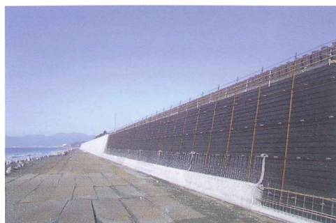
写真-5 施工状況(補強盛土の盛り立て)
