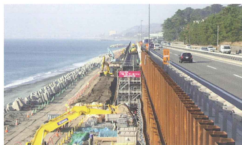
写真-4 施工状況(出典:横浜国道事務所 WEB サイト 4) )
