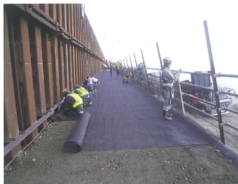
写真-2 ジオテキスタイルの敷設状況
