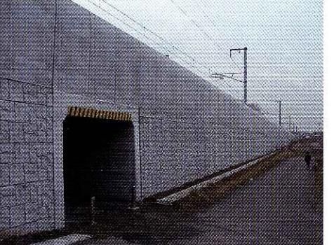
平成17年開通予定のつくばエクスプレス建設事業においては、つくば市の片田工区を担当し、トンネル出口から高架橋へのアプローチ部において、盛土高1.5m～6.0m延長482mにわたり、RRR工法による盛土工事を施工しました。
