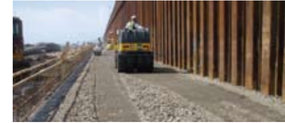
盛土転圧状況 Compaction of backfill
