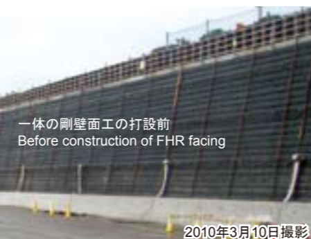
Restoration of a sea wall for seisho by-pass that collapsed by a typhoon 2007 to a GRS retaining wall. 平成19年の台風によって崩壊した西湘バイパス(神奈川県)海岸擁壁のGRS擁壁による復旧
